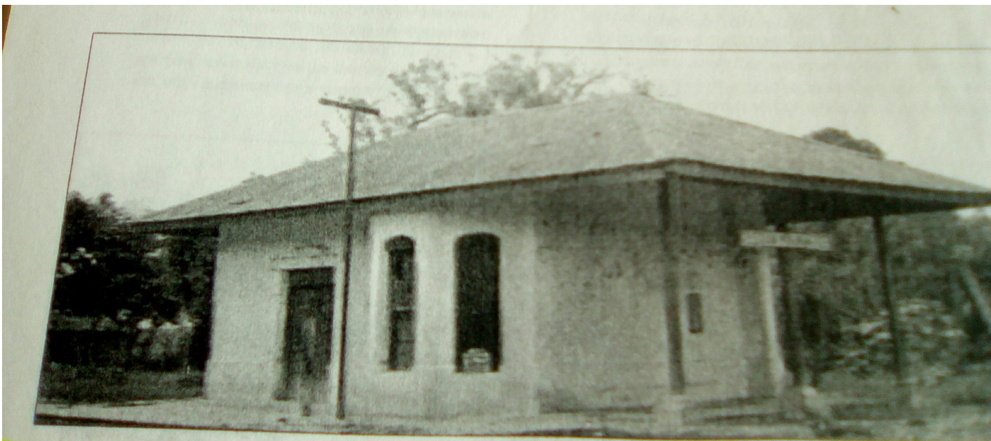
Estación La Polka km 194
